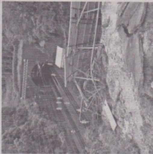
神戸市では豪雨で太陽光パネルが崩れ、新幹線の運行に支障が出た(2018年)
